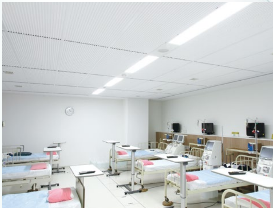
大阪市内某病院透析室 放射パネル施工例
