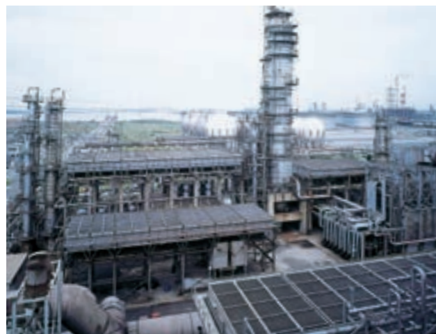
石油精製、石油化学プラントに設置された空冷式熱交換器
