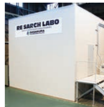
天井放射冷暖房パネル能力試験室 RE SARCH LABO
