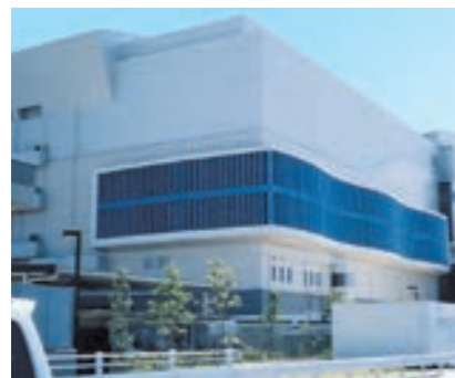
名古屋市猪子石工場様 蒸気復水器吸気騒音対策
