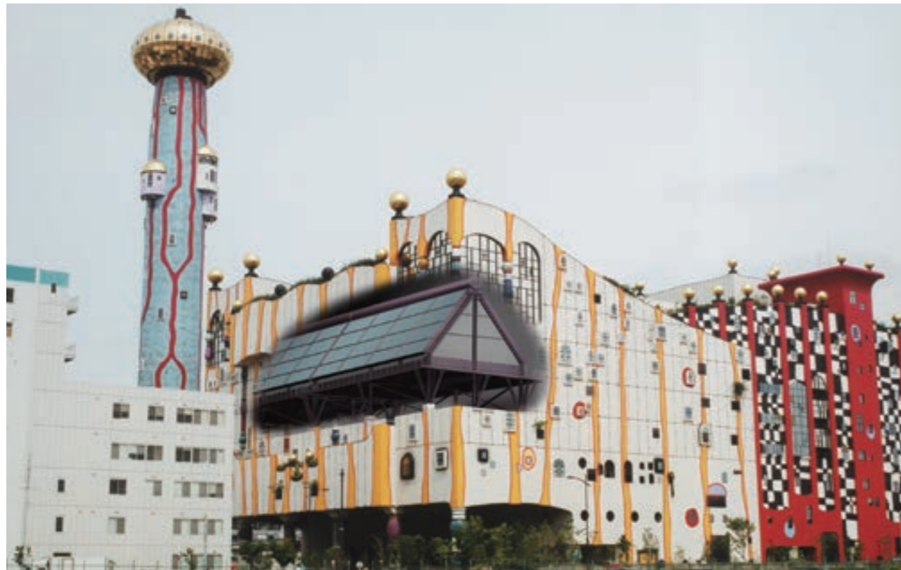
都市ごみ焼却プラントに設置された空冷式熱交換器
