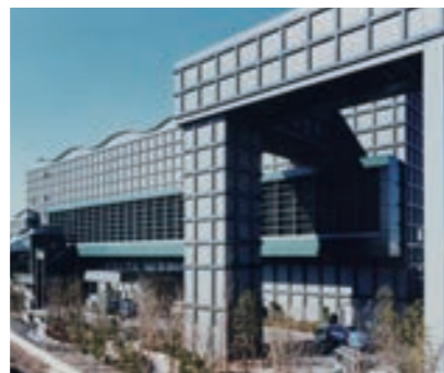
清掃工場 蒸気復水器吸気騒音対策
